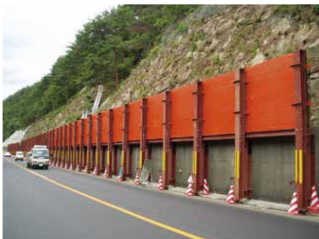
既設の擁壁を利用して設置
