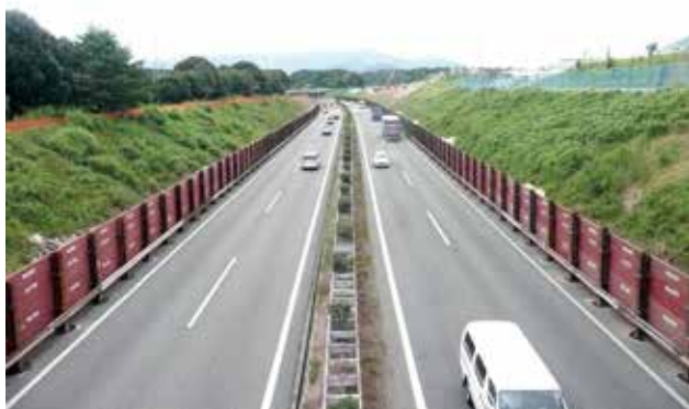
高速道路に設置
