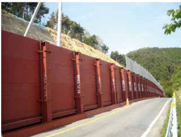
東日本大震災の復旧工事で設置
